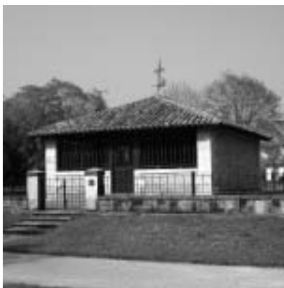
CASA DE LAS JUNTAS, PUENTE S. MIGUEL.
